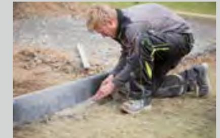
3. Setzen Sie Kantsteine zur Einfassung und Stabilisierung der Terrasse.
