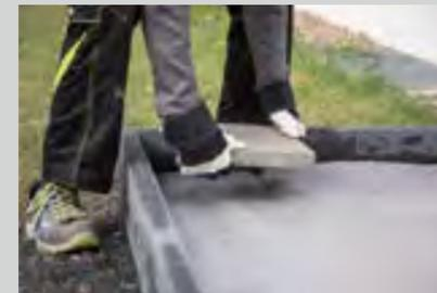
7. Legen Sie als Basis für die Stelzlager Betonplatten in regelmäßigen Abständen auf den Vlies.
